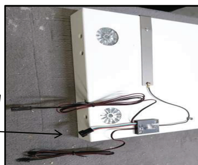
Wechselschalter an Bettseite verbaut
