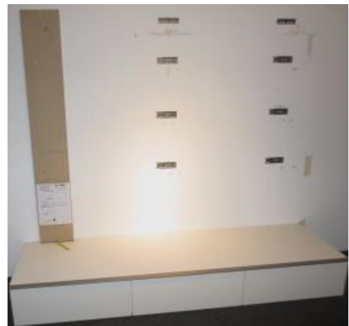
Bild 3: Bohrschablone außen bündig mit Unterteil anlegen und ausrichten
