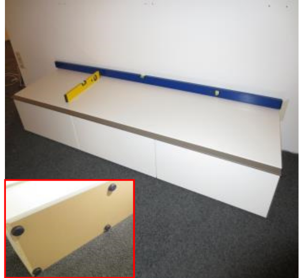
Bild 2: Stellfüße setzen, Unterteil ausrichten
