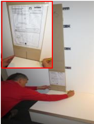
Bild 3: Bohrschablone außen bündig mit Unterteil anlegen und ausrichten
