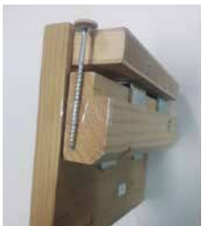
Variante für Einhängelasten: Diese mit einer Schraube von oben sichern und anschließend die Holzabdeckung auf dem Schraubenkopf stecken.
